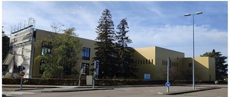
Achèvement du remplacement de l'ensemble des murs rideaux anciens du bâtiment (environ 1100 m<sup>2</sup>), renforcement de l'isolation des murs de façades (environ 500 m<sup>2</sup>) et des toitures (environ 630 m<sup>2</sup>), remplacement des luminaires par des solutions LED avec gestion des allumages, installation d'une seconde centrale de traitement d'air pour la ventilation et aménagement des locaux pour les nouveaux besoins + réalisation de l'Ad'AP
