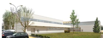
Remplacement de l'ensemble des menuiseries métalliques anciennes (environ 1000 m<sup>2</sup>), renforcement de l'isolation des murs de façades (environ 2370 m<sup>2</sup>) et des toitures (environ 2670 m<sup>2</sup>) et mise en place de 2 centrales de traitement d'air + réalisation de l'Ad/AP
