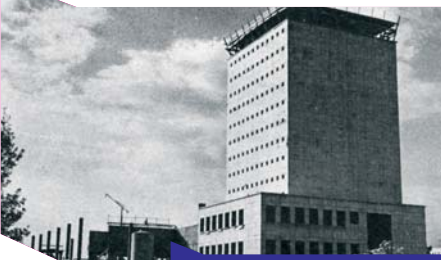
1961 - Construction de la BU Droit-Lettres
